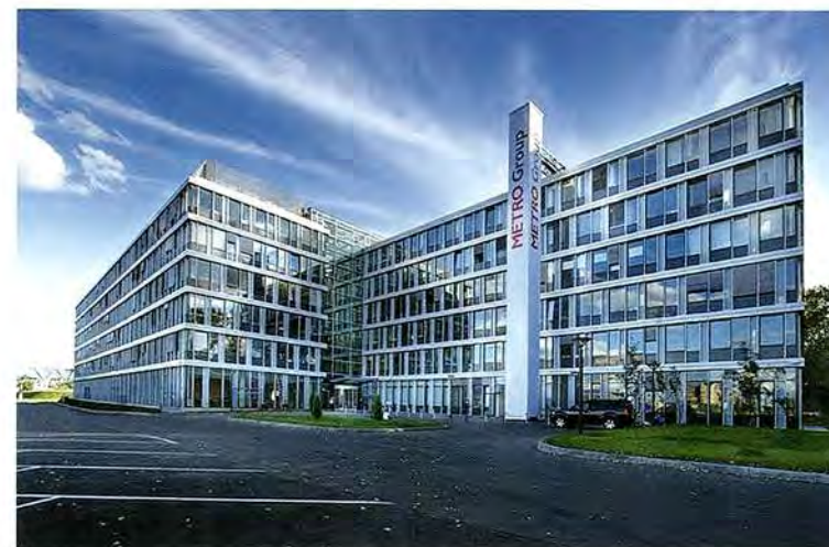
Das Moskauer Headquarter der Metro AG Baujahr 2004 – 2007
